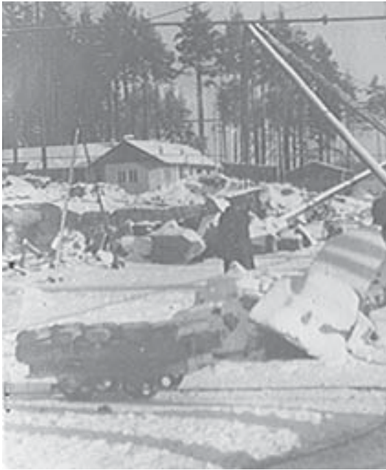
Obr. 5 Budova kanceláři na Hluboké a nižší dřevěné pasířny v pozadí. V pravé horní polovině snímku je patrný průsek lesa, který vedl směrem k Ležákům. Snímek byl pořízen v zimě 1941/1942. (AJB)
