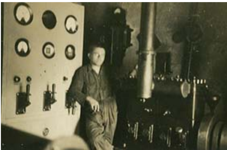
Obr. 3 Josef Bureš přímo ve strojovně na Hluboké. Nad kompresorem, u kterého jmenovaný stojí, byla v střešním meziprostoru umístěna Libuše. Ve vodních nádržích, které však snímek nezachycuje, byly v červenci 1942 dělníky nalezeny narychlo ukryté zbraně a rozmočené papírové krabice s náboji. (AJB)
